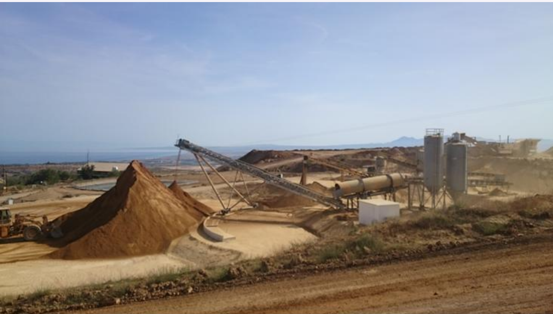
Τμήμα Συσσωμάτωσης Μεταλλεύματος
