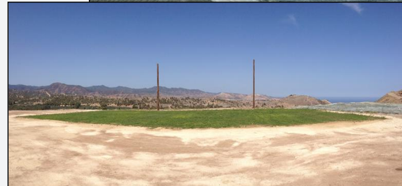
Αποκατάσταση οροφής σωρού εκχύλισης
