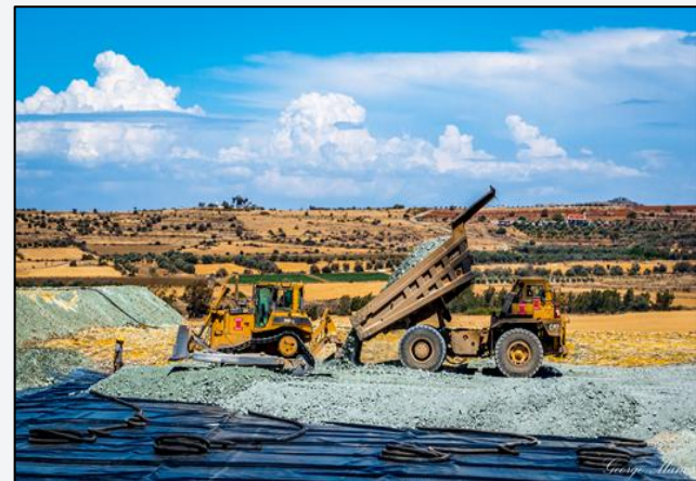
Κατασκευή σωρών εκχύλισης
