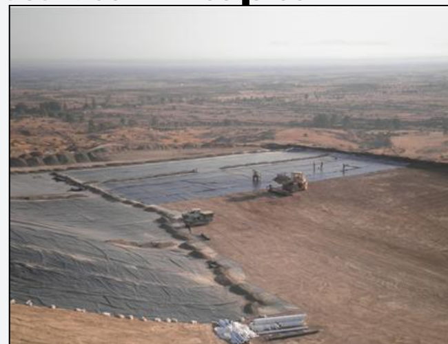
Κατασκευή βάσης των σωρών εκχύλισης
